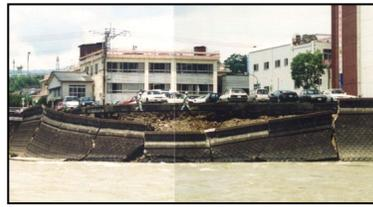
基礎洗掘により護岸が崩壊した事例(山田川合流点(H8.7.3~8の出水量))
