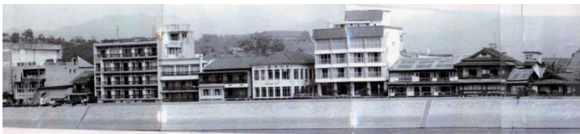
図 1.49 改修後の人吉温泉街の状況
