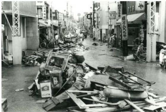
浸水後の状況(人吉市)
