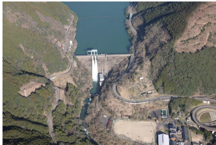
図 1.50 市房ダム（昭和 35 年（1960 年）3 月完成）
