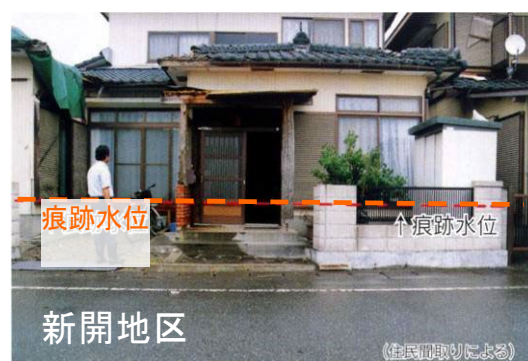
図 1.46 新開地区浸水状況（八代市新開町）
