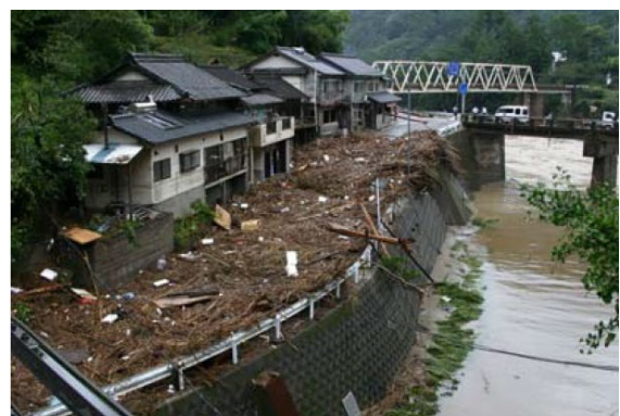
漆川内川浸水後の状況(芦北町)
