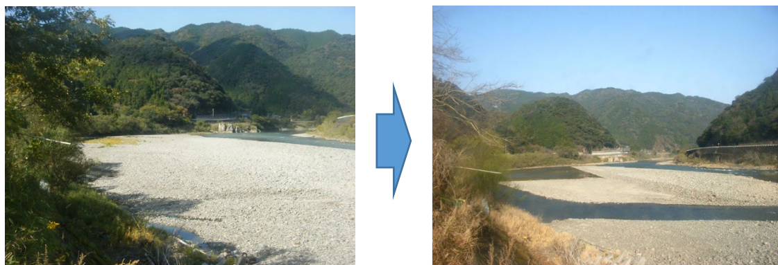
図 1.58 八代市坂本町の堆積土砂の掘削
