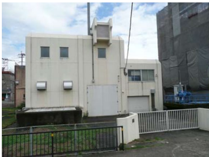
図 1.55 九日町排水機場（昭和 55 年（1980 年）3 月完成）
