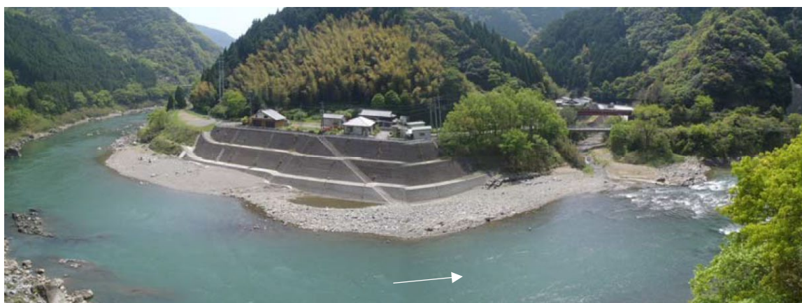
図 1.54 天月地区完成後の状況（芦北町）
