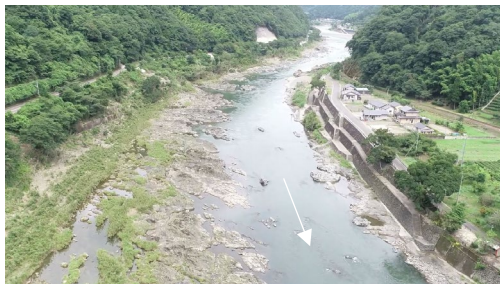
図 2.4 山間狭窄部状況写真(1)
