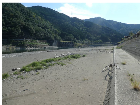
図 2.16 河道内の土砂堆積状況
