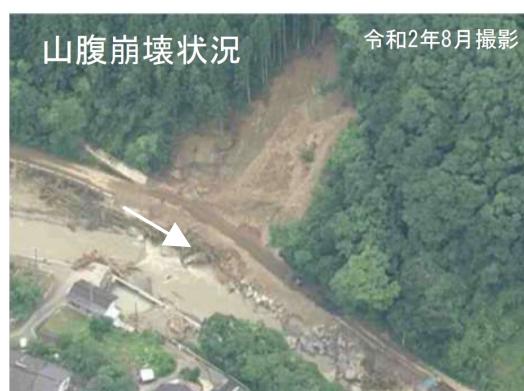
図 2.15 令和2年7月豪雨による 支川小川の山腹崩壊
