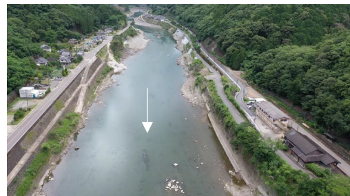
図 2.5 山間狭窄部状況写真(2)
