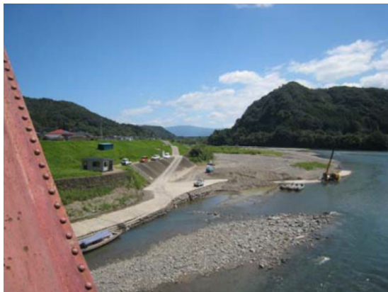
図 5.25 河道に堆積する土砂
