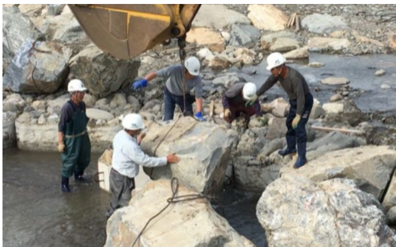
図 6.11 石工の巨石設置の技術（八の字堰の施工状況）
