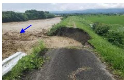
令和 2 年 7 月豪雨による免田川の堤防欠損状況
