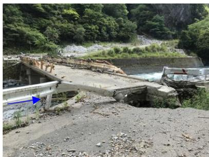
写真 2.2 梶原川の土砂・流木による橋梁の被害状況（令和2年7月豪雨）
