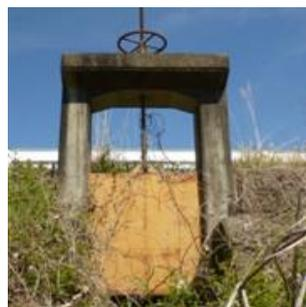
写真 2.7 老朽化した樋管
