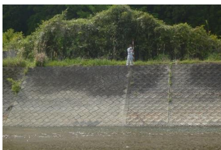
写真 5.11 河川点検・巡視の状況
