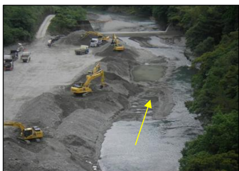
写真 5.13 ダム湛水区間における堆砂土砂の掘削や流木・ゴミの除去（市房ダム）
