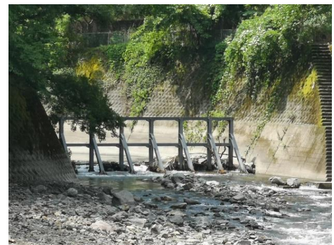
写真 5.2 流木止工施設の例 (油谷川下流)
