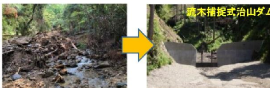
写真 5.3 関係機関による土砂・流木対策の例
