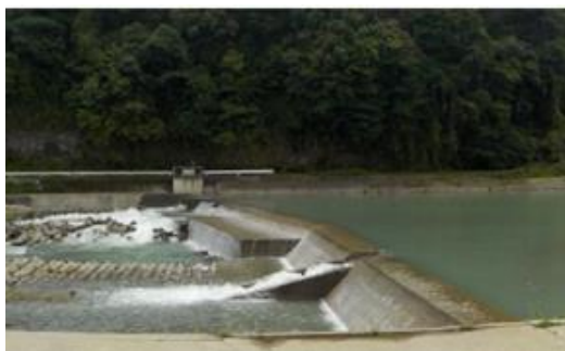
写真 5.9 堰の魚道（万江川）
