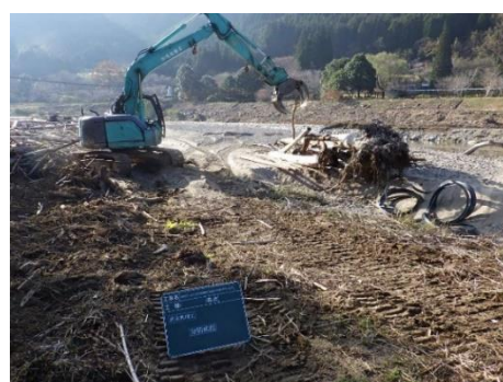
写真 5.13 ダム湛水区間における堆砂土砂の掘削や流木・ゴミの除去（市房ダム）
