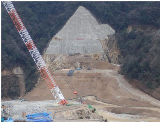
貯水地法面对策工(押え盛土工)の例
