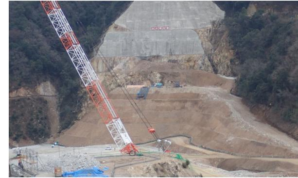
貯水地法面対策工(押え盛土工)の例
