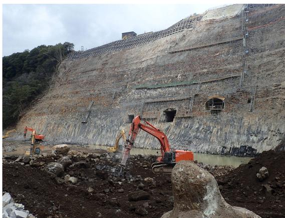
基礎掘削状況(立野ダムの事例)
