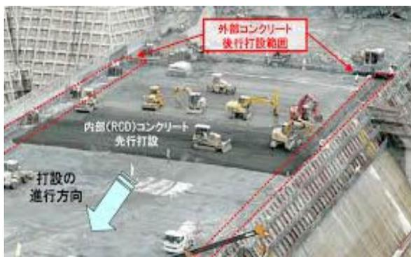
コンクリート打設状況(津軽ダムの事例)
