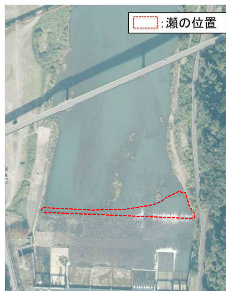
H21（八の字堰施工前） 約4,000㎡
