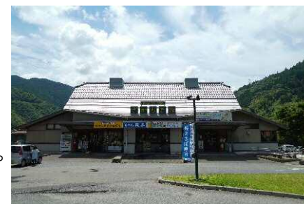
被災前の広域交流センターさかもと館 (道の駅坂本)
