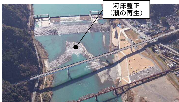
遙拝堰下流の状況 (令和4年1月8日撮影)
