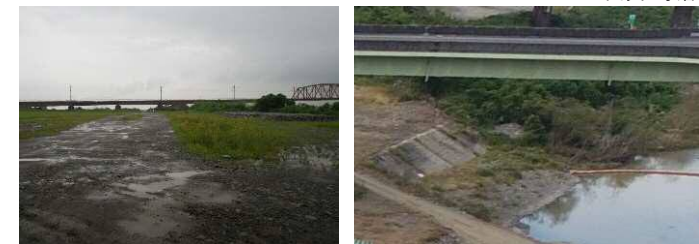
遙拝堰下流左岸高水敷、水際の状況(整備前)
