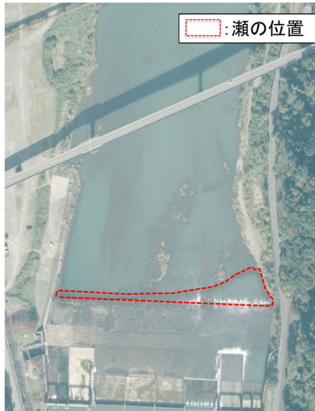
H21(八の字堰施工前) 約4,000m 2
