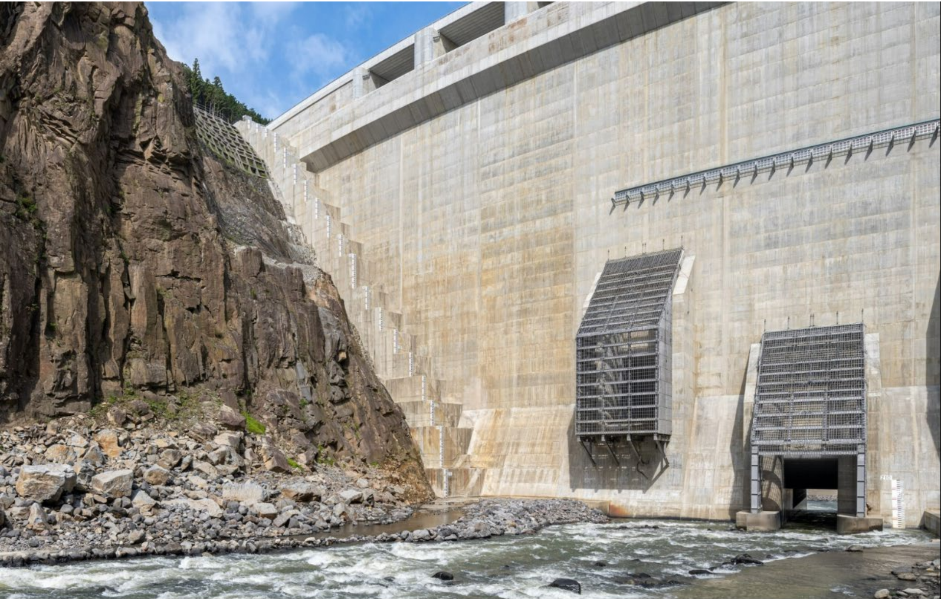
上流側の河床部放流設備（常用洪水吐きの長さは約70m）
