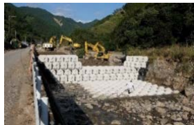
【仮設土砂止め】
