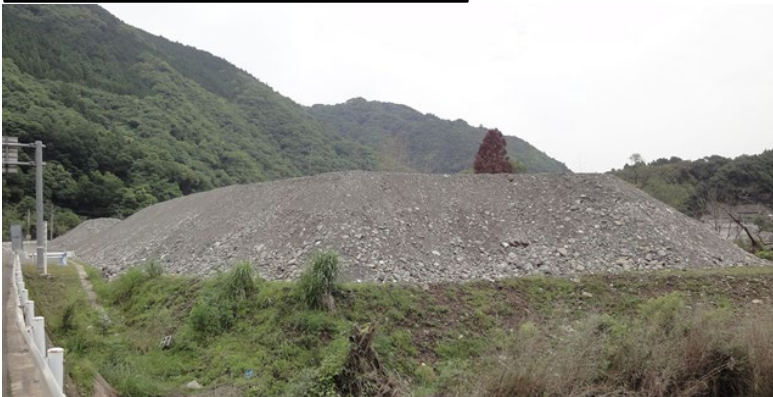
道の駅坂本 下流側【仮置き】
