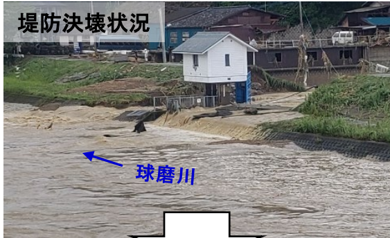
㉗堤防決壊箇所(球磨川右岸56.4k付近)
