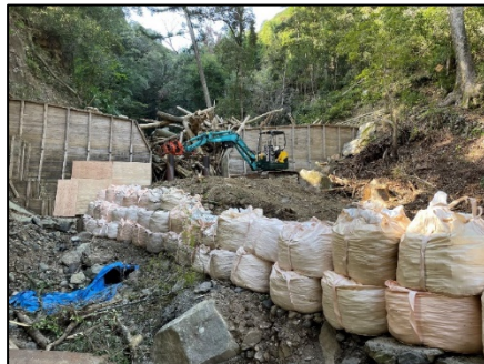
堆積した流木の除去状況
