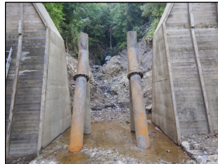
流木の撤去後
