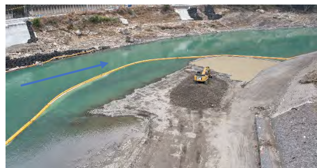
汚濁防止フェンスの設置状況
