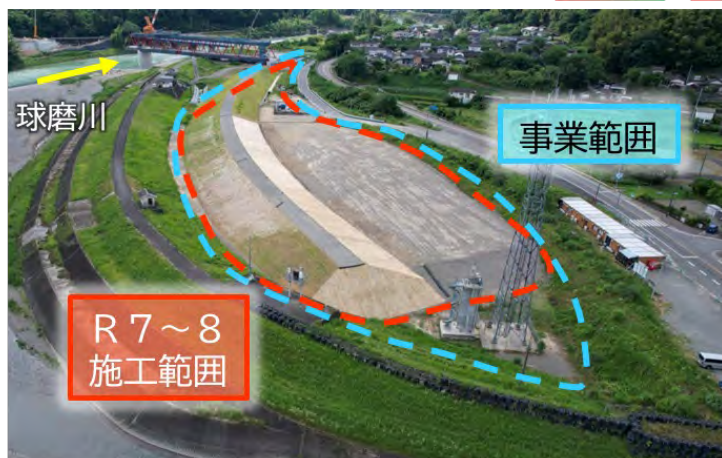
渡地区引堤工事施工状況(R7.7)【球磨村渡地区】
