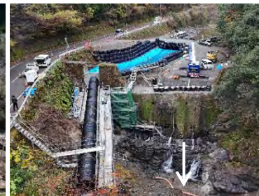
小川砂防堰堤改築 (施工中)
