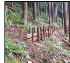
丸太筋工（湯前町）
