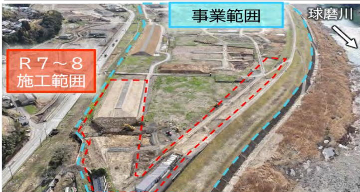
渡遊水地施工状況(R8.3)【球磨村渡地区】
