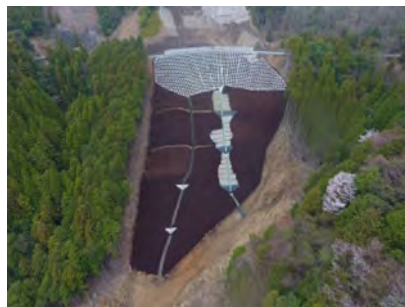
崩壊箇所の山腹工による復旧(八代市)
