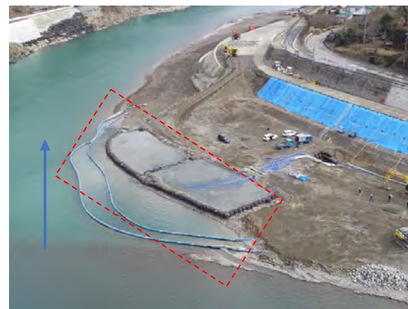
沈砂池設置状況
