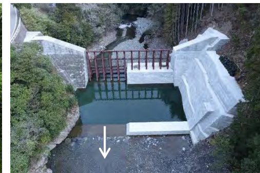
小川第2砂防堰堤 (R8.3完成)
