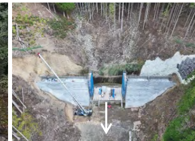
縦木川第3砂防堰堤 (施工中)
