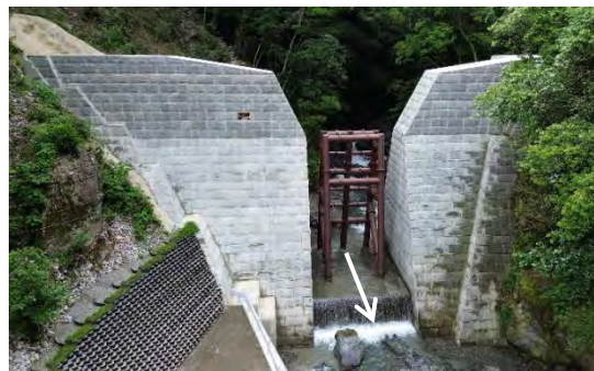
入鴨川第8砂防堰堤 (R7.6完成)
