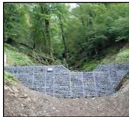
治山ダム（あさぎり町）
