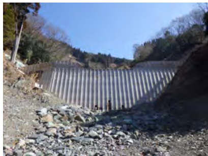
土石流発生源での治山ダム整備(五木村)
