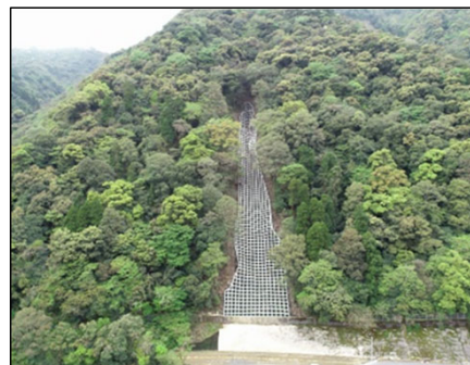
崩壊箇所の山腹工による復旧（球磨村）
