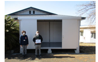
防災倉庫の整備（多良木町）
