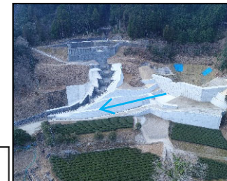
②九折瀬第3砂防堰堤(R4.3)
