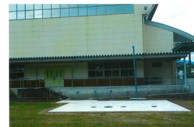
マンホールトイレの整備 （多良木町）
