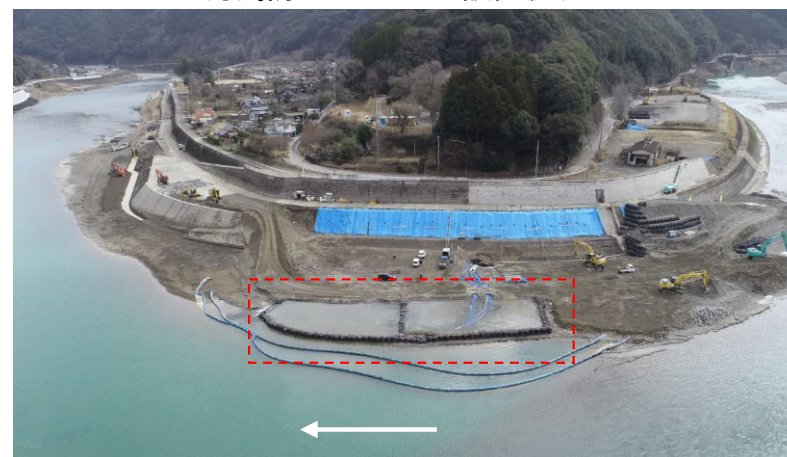
沈砂池設置状況
