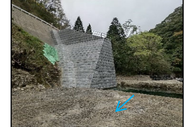
⑤小川第2砂防堰堤
