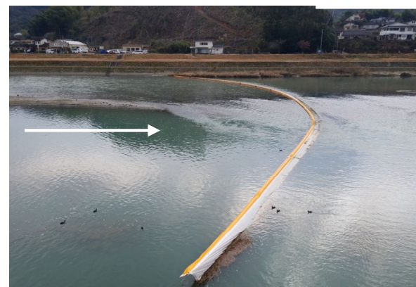
汚濁防止フェンスの設置状況
