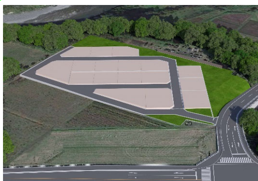
被災者の安心安全な居住地の確保及び 移住定住者向けの宅地分譲地整備 R5.6工事完了
