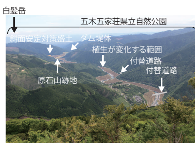
(試験湛水直後)
