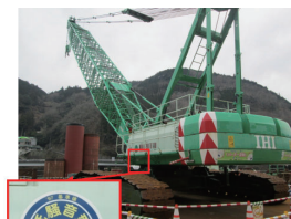
低騒音型建設機械の状況
