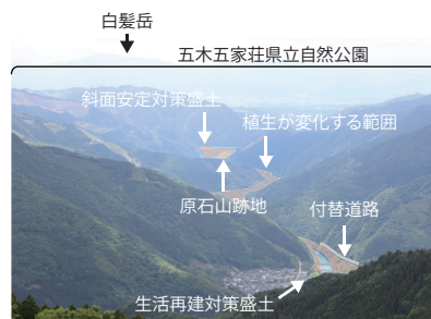
(試験湛水直後)
