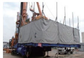
防音シートの設置の状況
