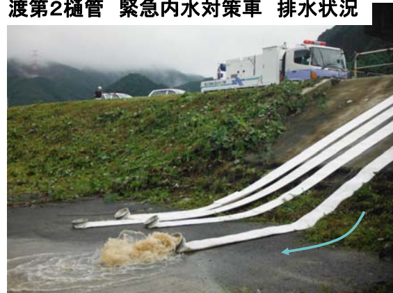
渡第2樋管 緊急内水対策車 排水状況
