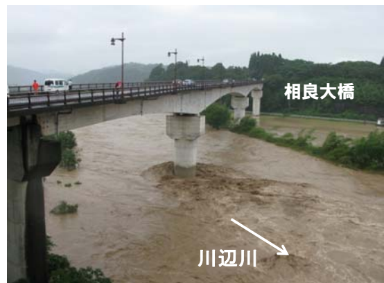
相良大橋を望む【川辺川】 (12日13時30分頃)
