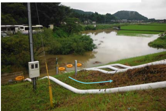
今村第2樋管 川裏 ポンプ投入状況
