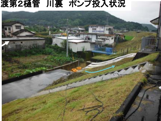
渡第2樋管 川裏 ポンプ投入状況
