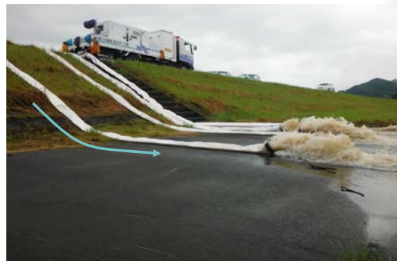
今村第2樋管 緊急内水対策車 排水状況
