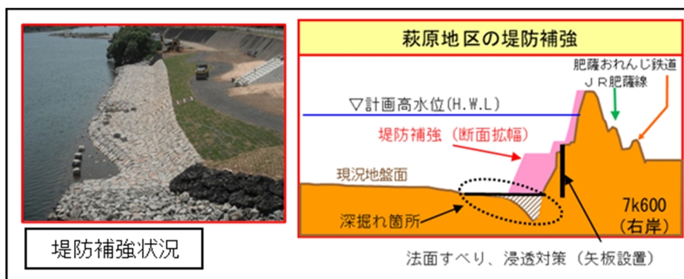
図 八代市萩原地区の堤防補強
