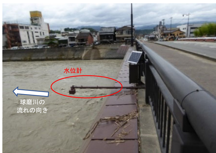
写真1 危機管理型水位計の設置写真
