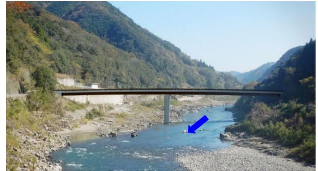
松本橋【鋼2径間連続鋼床版箱桁橋】
