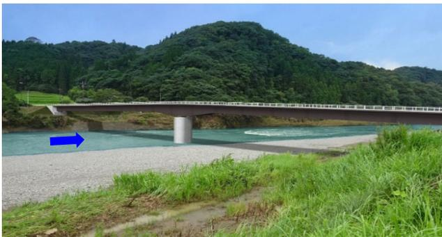
沖鶴橋【鋼2径間連続鋼床版箱桁橋】
