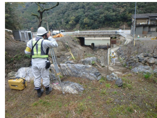
球磨村多武除地区 測量状況(R4.11.18)
