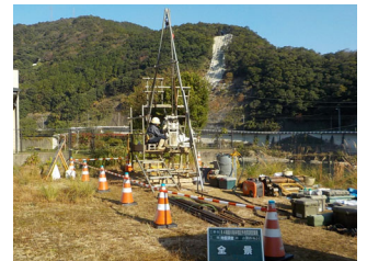
八代市原女木地区 地質調査状況(R4.11.18)
