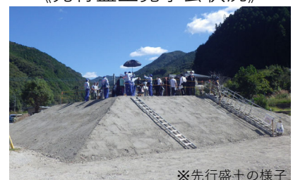
※先行盛土の様子
