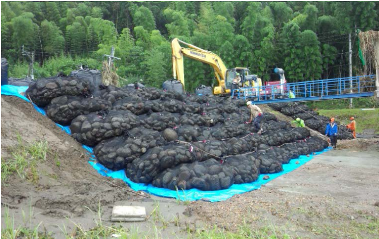
2020.07.09 9時30分頃 復旧完了(堤防川側)
