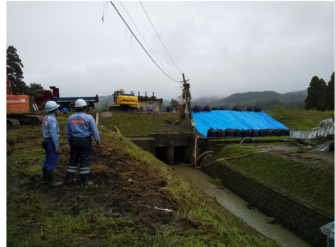
2020.07.09 9時30分頃 復旧完了(堤防裏側)
