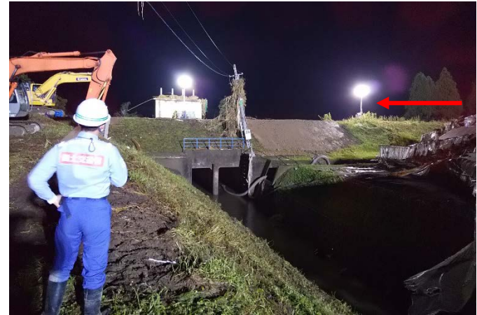
2020.07.09 3時00分頃 仮堤防概成
