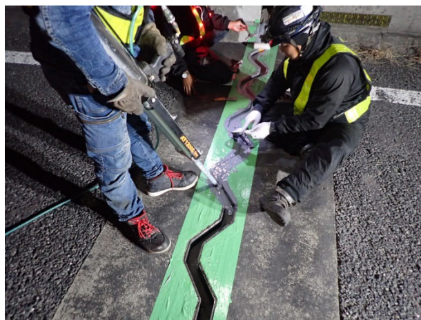
< 止水材取替工事 >
