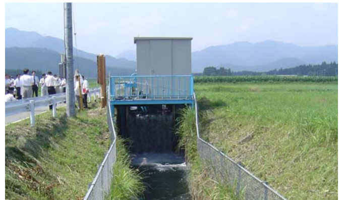
(発電所設置後)
