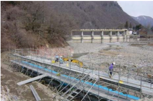
河川区域内での工事例
