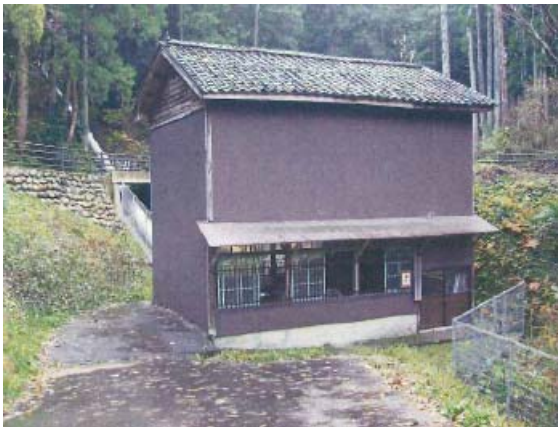
▲発電所建屋の状況
