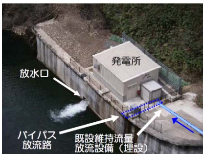
▲ 発電所設置後の現況
