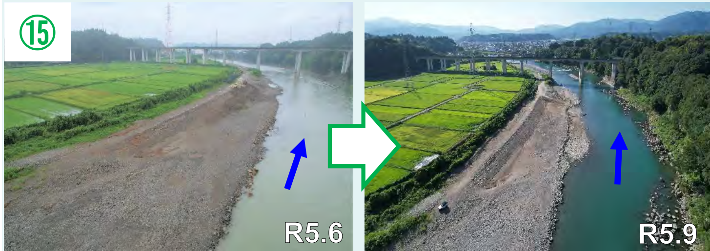
63k500左岸 球磨川第三橋上流付近(七地地区)
