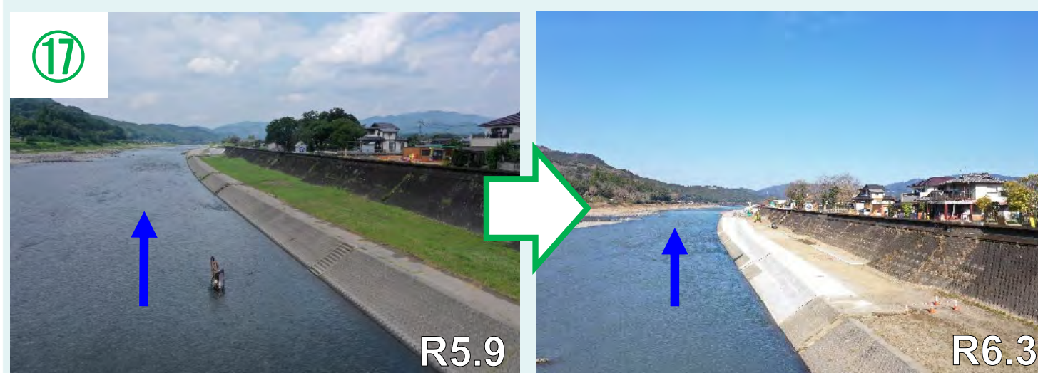
59k000左岸 西瀬橋下流付近(下薩摩瀬地区)
