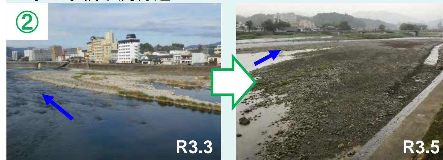
61k800右岸 水の手橋下流付近
