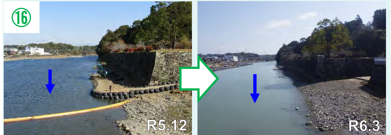
62k200左岸 球磨川水の手橋上流付近(九日町地区)
