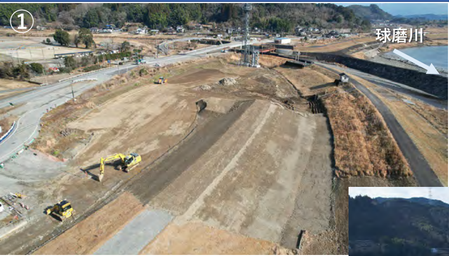
施工状況（令和7年1月末時点）
