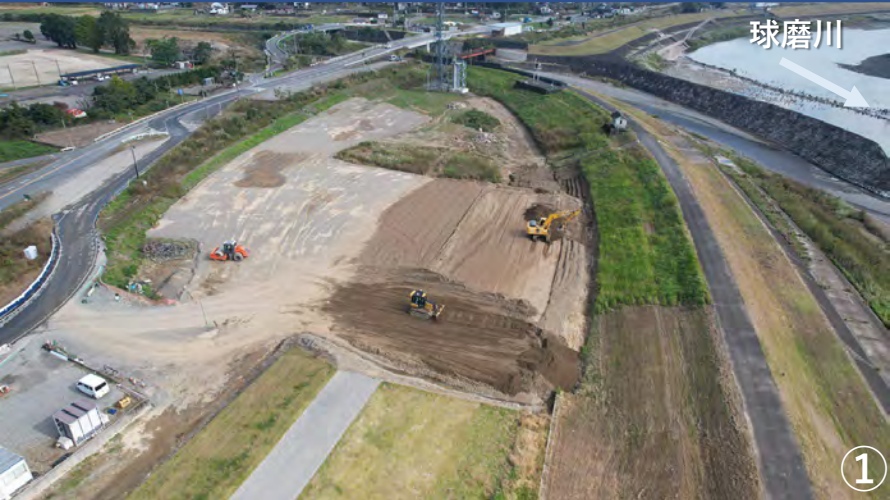
施工状況（令和6年11月末時点）
