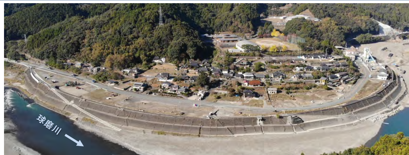
施工状況（令和5年12月末時点）
