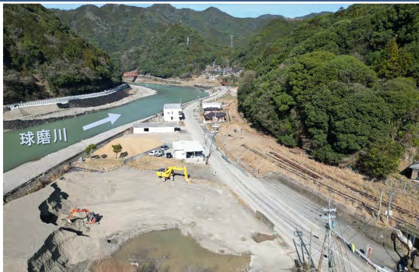
施工状況（令和6年3月末時点）
