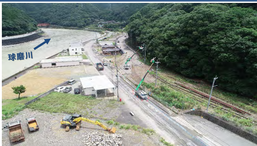
施工状況（令和6年9月末時点）
