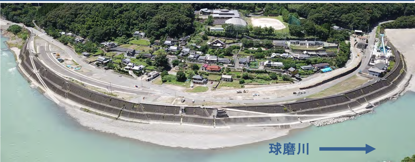
施工状況（令和6年9月末時点）
