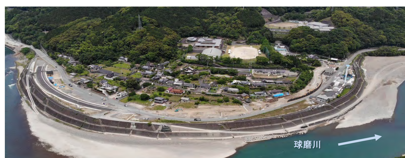
施工状況（令和6年5月末時点）
