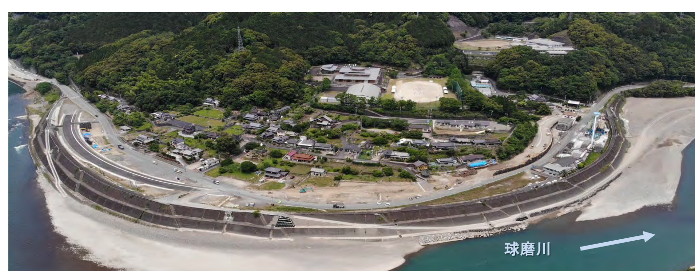
施工状況（令和6年5月末時点）
