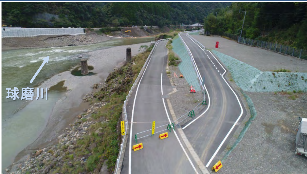
施工状況（令和7年1月末時点）
