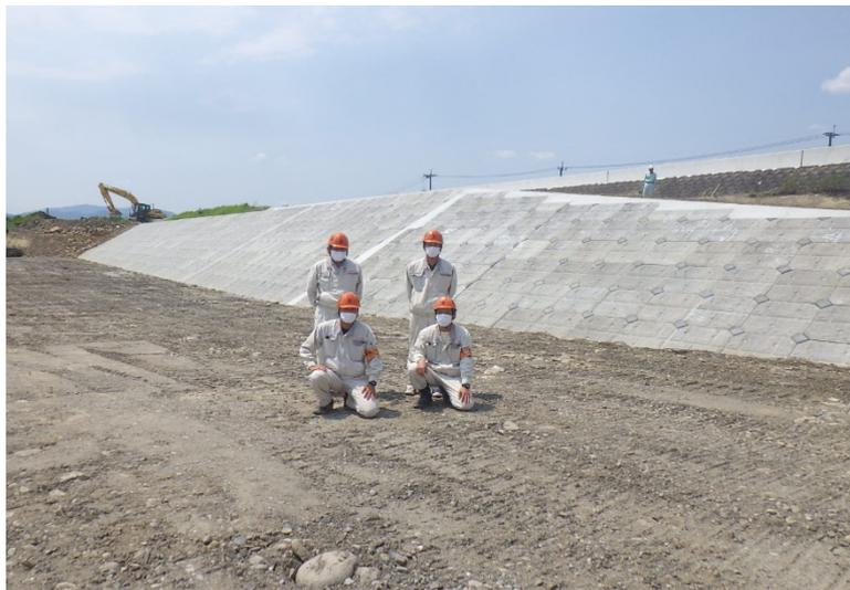
本工事は、現場が4箇所にある災害復旧工事です。その中で1番に優先された下薩摩瀬地区の紹介をします。令和2年7月豪雨で被災した箇所を、豪雨後に応急復旧した部分を当工事にて、堤防盛土、大型ブロック張工、パラペット工等の施工を行い、また高水敷付近の河川断面確保の為、追加にて掘削、ブロック張工等工事を行いました。今年は例年より早い梅雨入りとなり、工程管理に配慮しながら休日を返上し、水位が下がるのをまっでの施工になりました。近くには民家が多く、家屋の復旧作業などされていまして、住民の方が進捗状況など見られにいられていましたので、施工方法や工程の説明等行い協力して頂きました。急速な施工ではありますが、高品質な製品確保に努めました。
