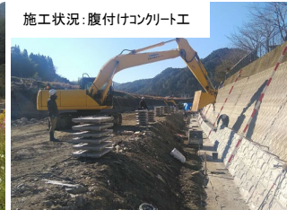
施工状況：腹付けコンクリート工
