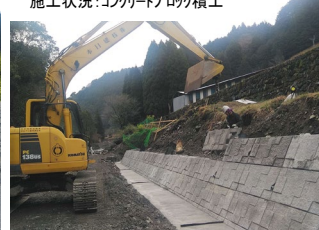
施工状況：コンクリートブロック積工
