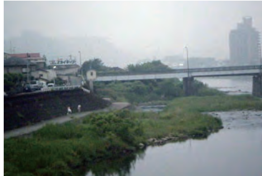
散歩道路（新町側）
