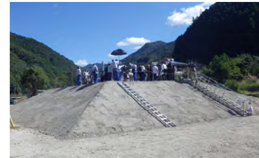
先行盛土完成
