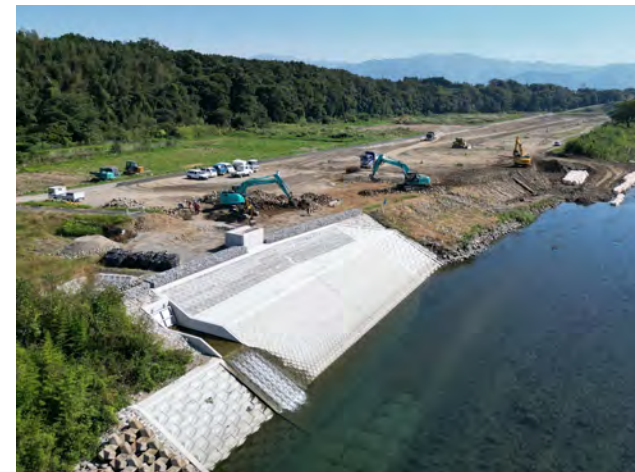
遊水地工事の状況(R5.10.23) 【相良村柳瀬地区】
