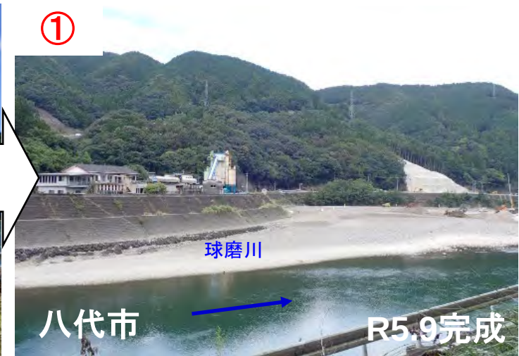
【施工後完了状況】
