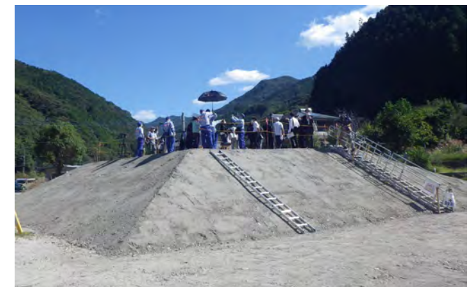
先行盛土完成
