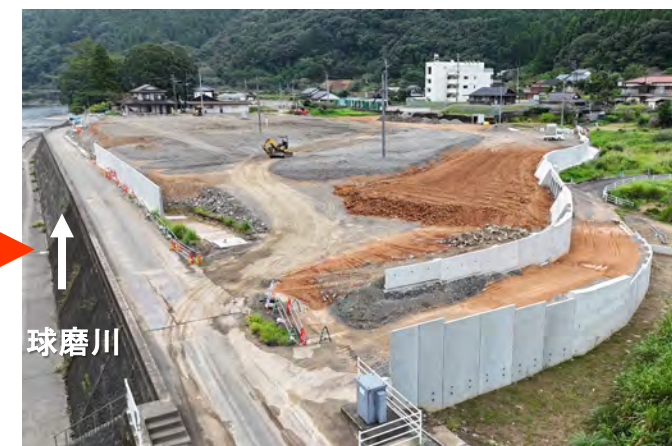
施工中 R7.9末時点
