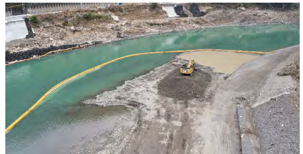
汚濁防止フェンスの設置状況
