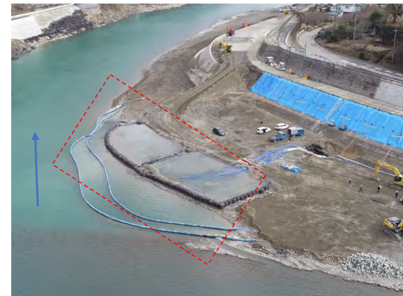
沈砂池設置状況
