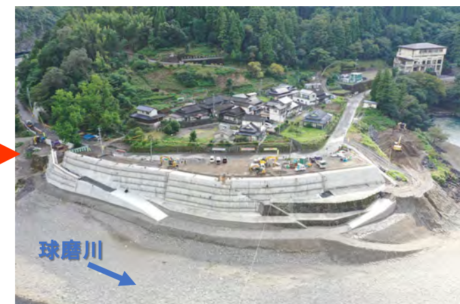
施工中 R7.9末時点
