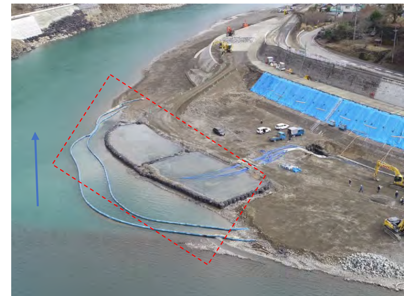
沈砂池設置状況
