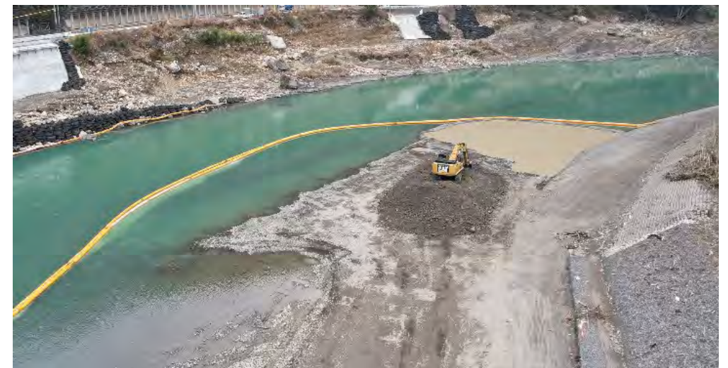
汚濁防止フェンスの設置状況
