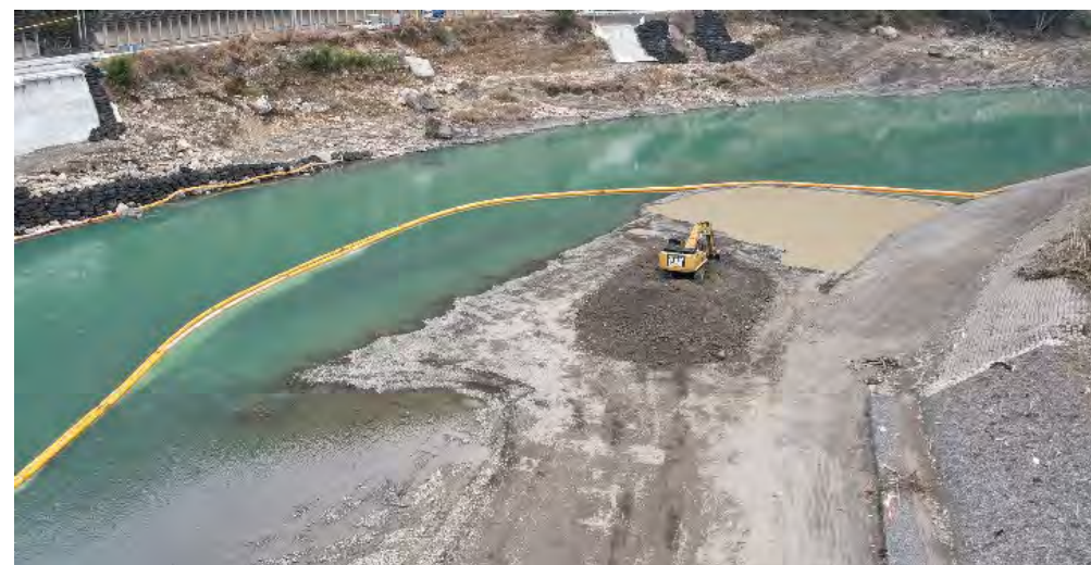
汚濁防止フェンスの設置状況
