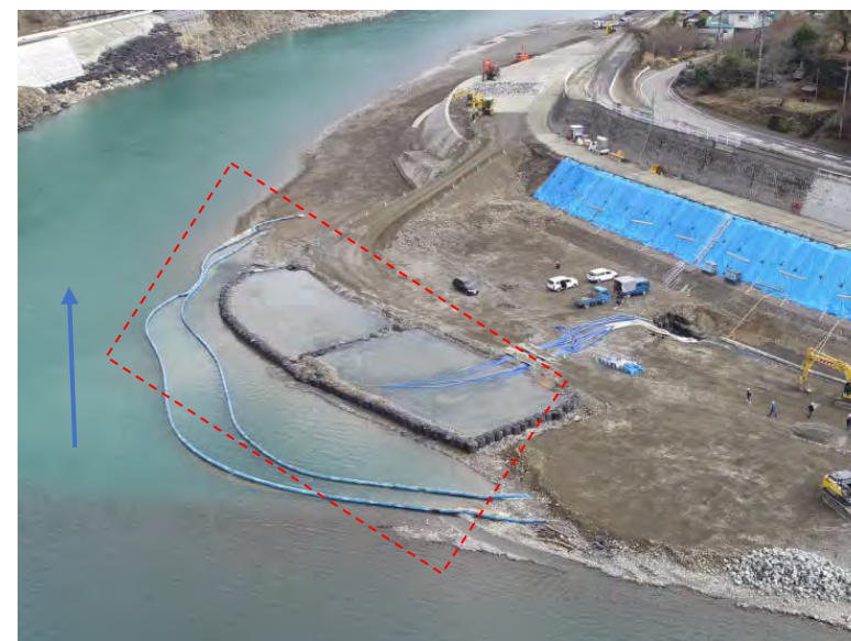
沈砂池設置状況
