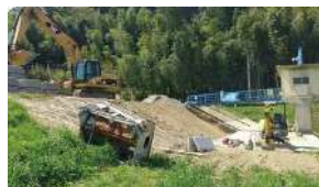
本復旧作業中(令和3年4月7日)
