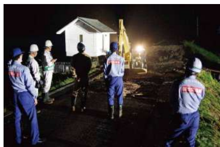
緊急復旧工事着手
