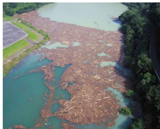
第2貯砂ダム付近流木捕捉状況
