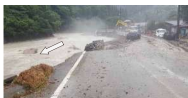
① 万江川・兼用護岸一部欠損
