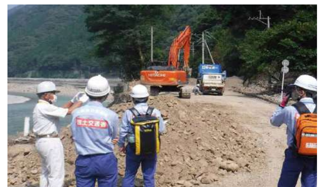
堆積土砂撤去(球磨村神瀬地区)
