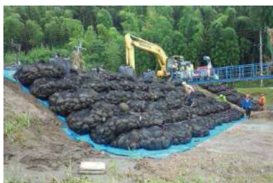
復旧完了(堤防川側)
