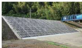
本復旧完了(令和3年5月24日)
