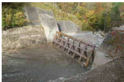
除石完了(約3,600 m 3 )
