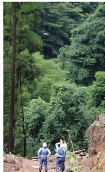
ドローンによる現地調査
