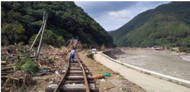
土石流等の被害 (JR肥薩線 吉尾地区)
