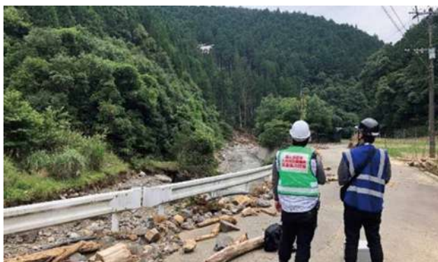
ドローンによる施設状況確認
