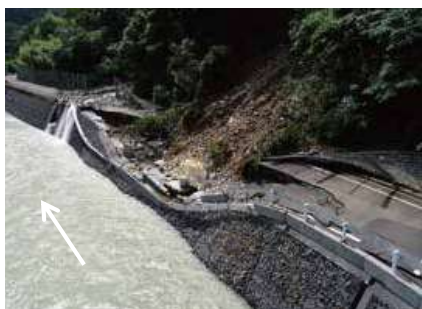
五木小川右岸0 k 200付近
