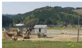
本復旧作業中(令和3年4月21日)
