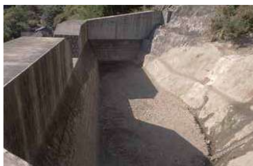
除石完了(約1,700 m 3 )
