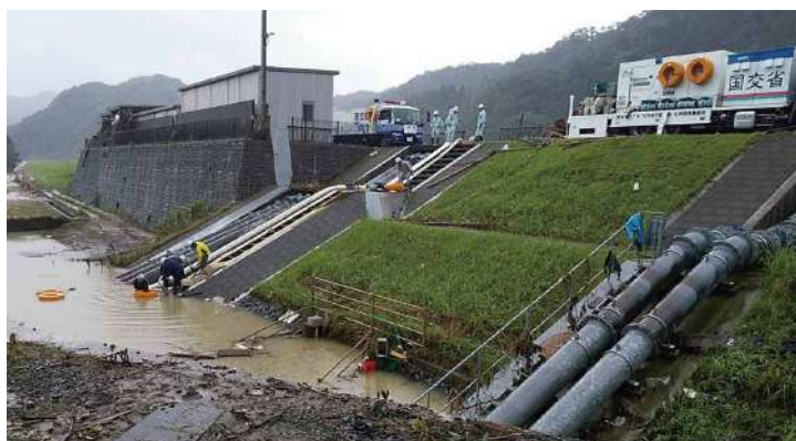
今村第2樋管での排水作業
