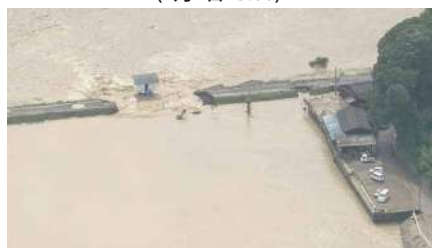
球磨川56k400付近の堤防決壊箇所(7月4日撮影)
