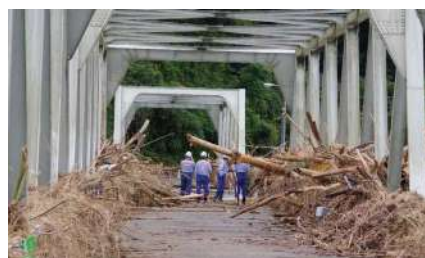
西瀬橋 流出箇所調査状況
