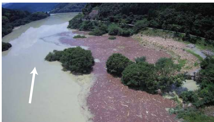
第1貯砂ダム付近流木捕捉状況
