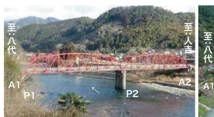
被災前の状況(平成15年3月時点)
