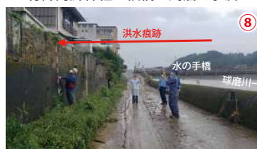
堤防を2m程度上回る高さに洪水痕跡を確認(水の手橋下流右岸)
