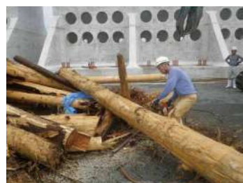
陸揚げした流木の切断作業 (7月7日)
