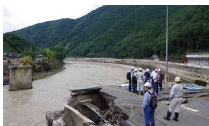
現地調査状況(鎌瀬橋)
