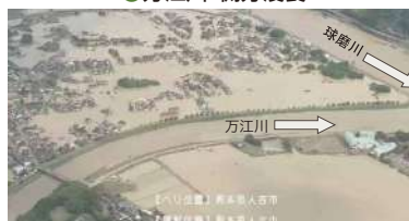
③ 万江川(本川合流部)の浸水状況
