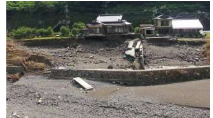
③ 護岸被災 (八代市坂本町中津道地先)
