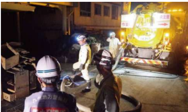
排水管清掃(7月13日:人吉市)
