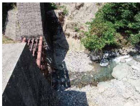
久連子第7砂防堰堤 (堰堤高14.5m、 堰堤長63.8m)
