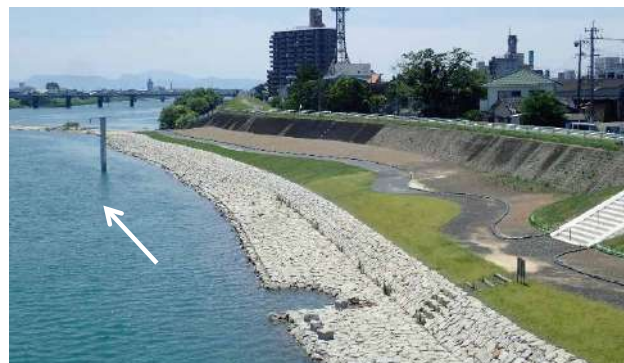
堤体下部整備完了状況(令和2年6月)
