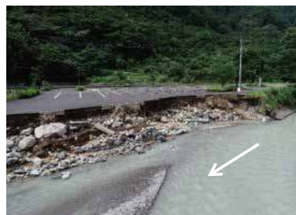
五木小川右岸0 k 800付近
