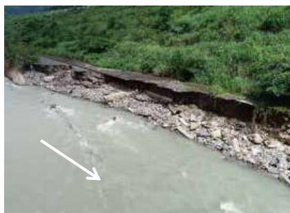
五木小川左岸0 k 700付近
