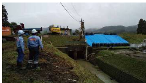
復旧完了(堤防裏側)
