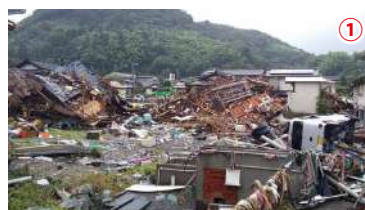
球磨川右岸から約50m離れた場所での家屋倒壊(球磨村渡地区)
