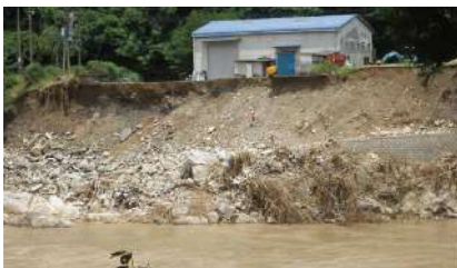
① 護岸被災 (八代市坂本町西部地先)
