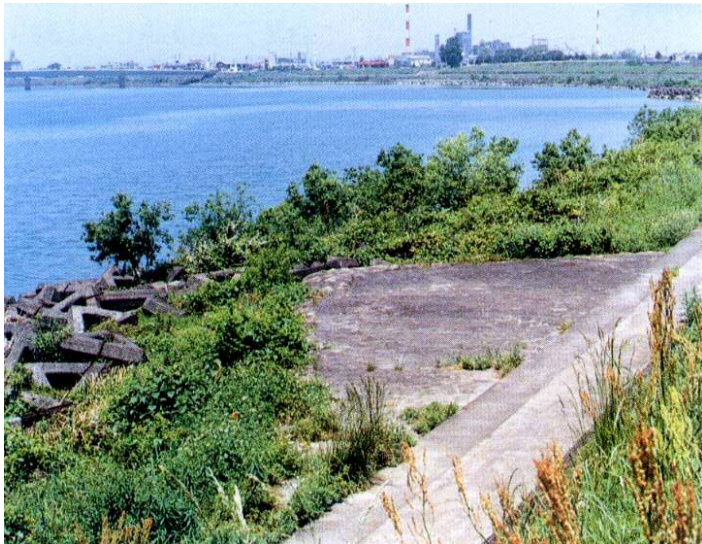
はね石 : 清正の巧みな治水技術として有名なはね石。清正は萩原堤の水衝部にこの石はねを設け、水の流れを流心に向かわせる工夫をした。
