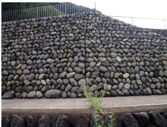
表面に凹凸があるため、立体感がある。明度、彩度ともに低いため、周辺環境になじみやすい。ただし、流速が早いところで使用する場合、崩れる可能性があるため、玉石の裏にコンクリートでしっかり練積みを施す必要がある。調達先としては、球磨川周辺で入手できると考えられる。
