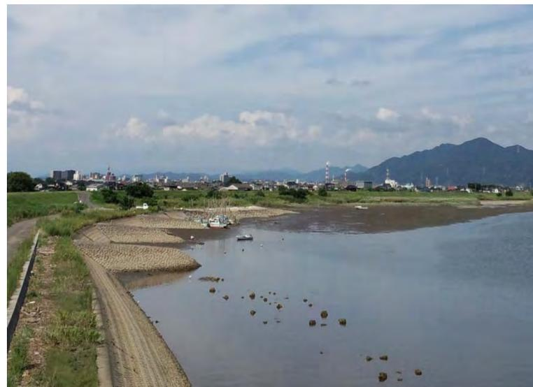
根固ブロックをアンコにして表面は間知石にて水制工を施工、干潮時でも根固ブロックが見えないように石組みを行っている。(球磨川)
