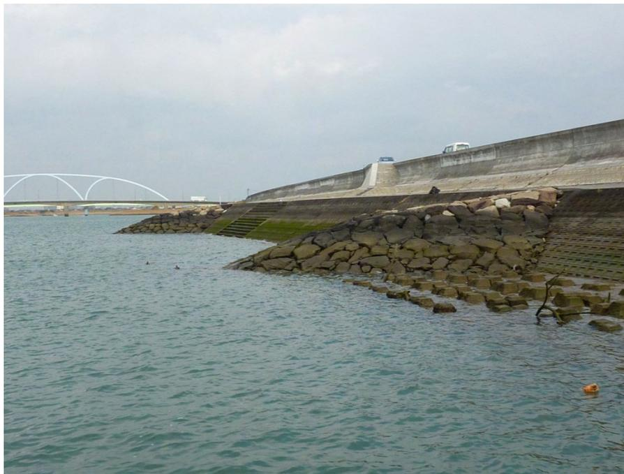
割石乱積の巻天端水制（球磨川）
