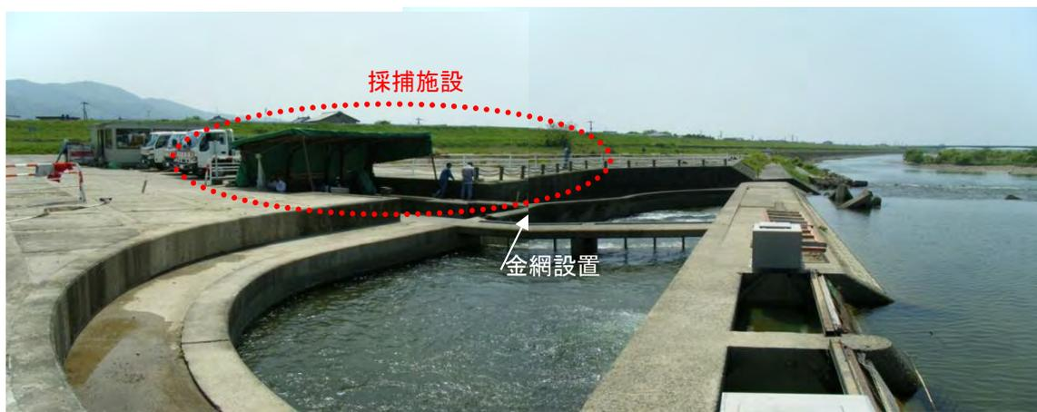
球磨川堰左岸部に設置された魚道(階段式)、鮎採捕場が隣接されています。
