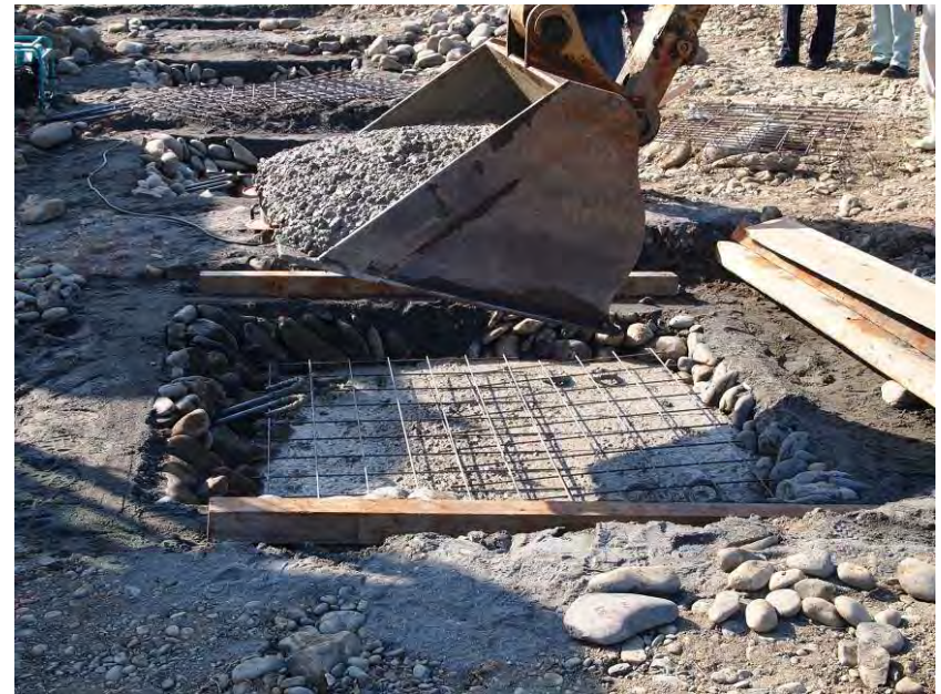
コンクリート打設
