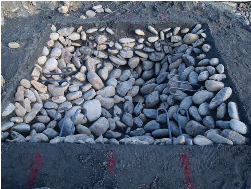
地面を掘削し、砂を敷き、玉石、シャックルを設置
