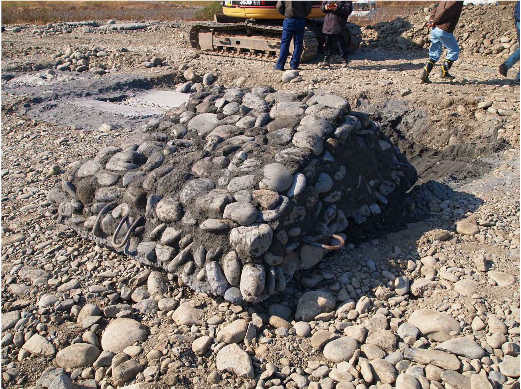
完成(約3トン程度)、特に水で洗淨する必要ない。砂であるから、そのまま河川内に設置可能
