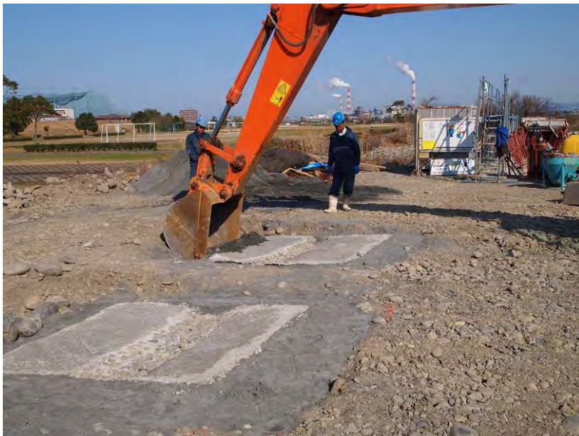
コンクリート打設後、3日後、脱枠、BFで掘り上げる
