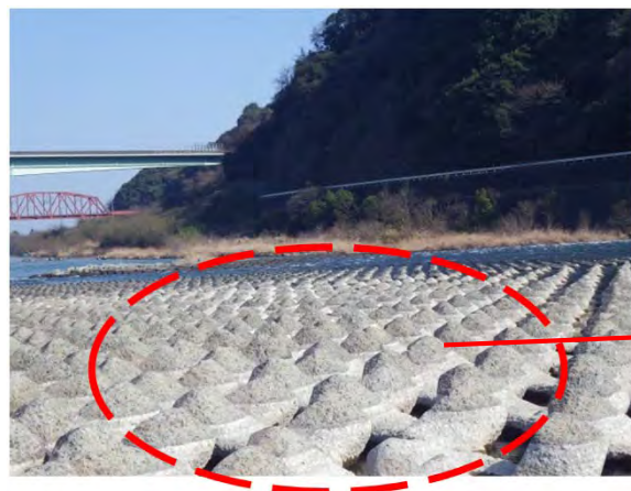
護床工で見られる河床材料（1～10cm）
