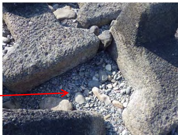
護床工で見られる河床材料（1～10cm）
