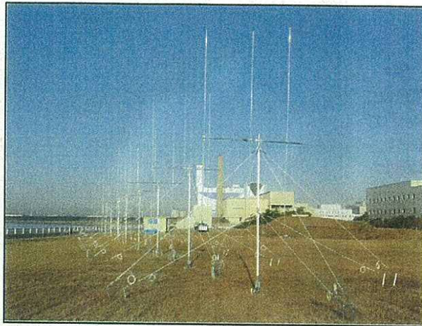
図-3 海洋短波レーダーアンテナ設置例
