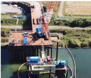
▲写真 ジャイロプレス工法による施工状況
