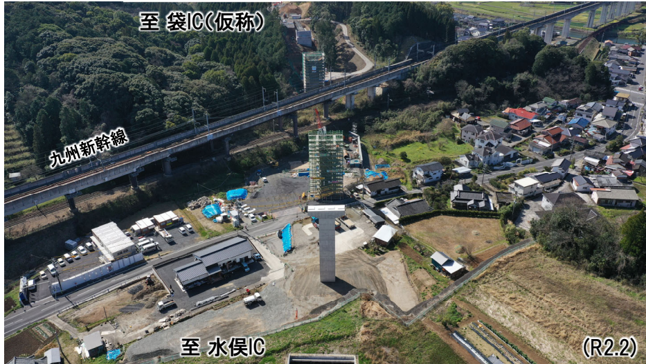
▲ 古城第2橋 施工中[上部工架設前](写真②)
