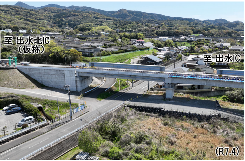
▲ 美原橋施工状況(写真①)
