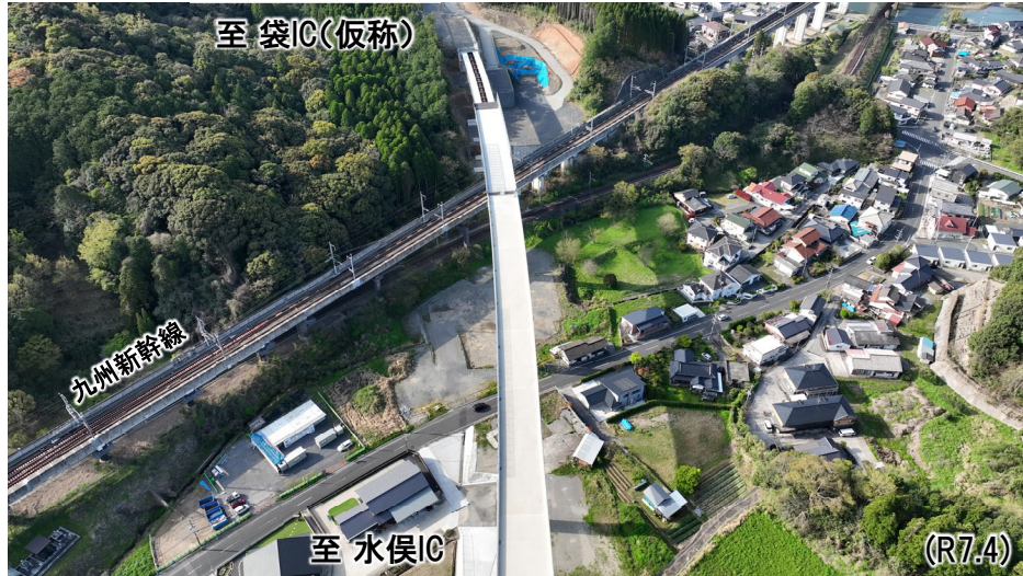
▲ 古城第2橋 施工中[上部工架設後](写真③)
