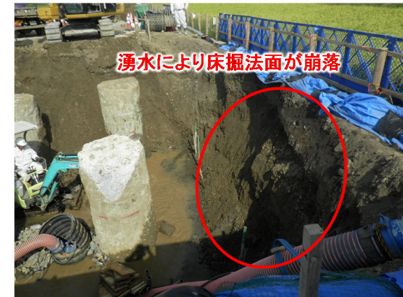
▲写真 ろくがっだ 六月田橋現地施工状況(オープン掘削施工)
