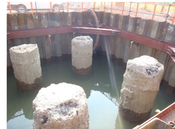
▲写真 ろくがっだ 六月田橋現地施工状況(仮締切施工)
