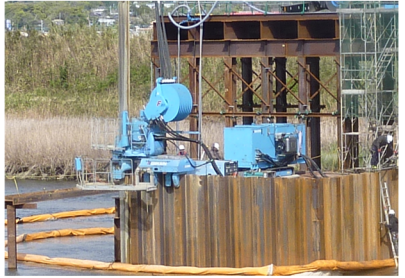
▲写真 硬質地盤クリア工法による施工状況
