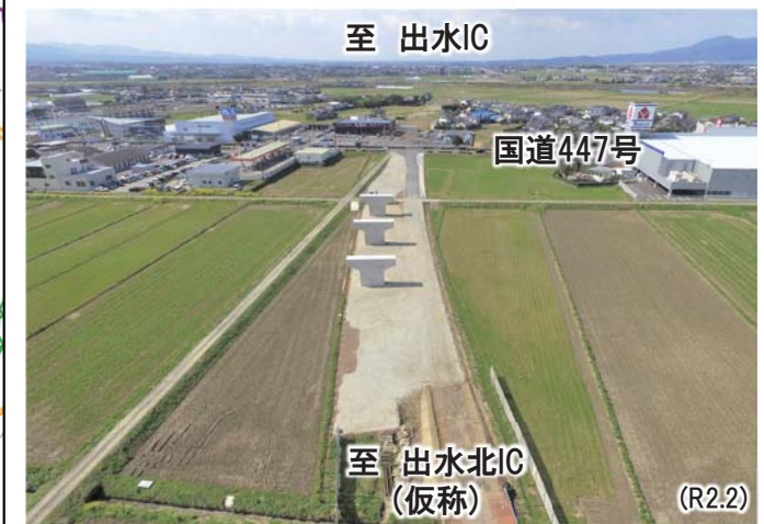
▲橋梁工事状況（写真④）
