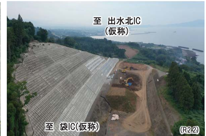
▲改良工事状況（写真③）
