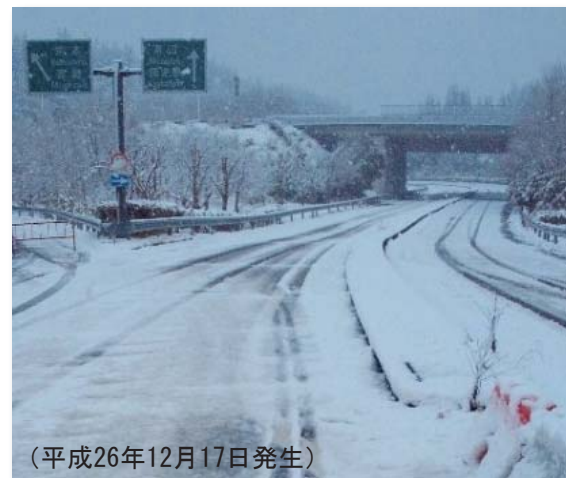
▲ えびのJCT付近の積雪状況 (写真①)
