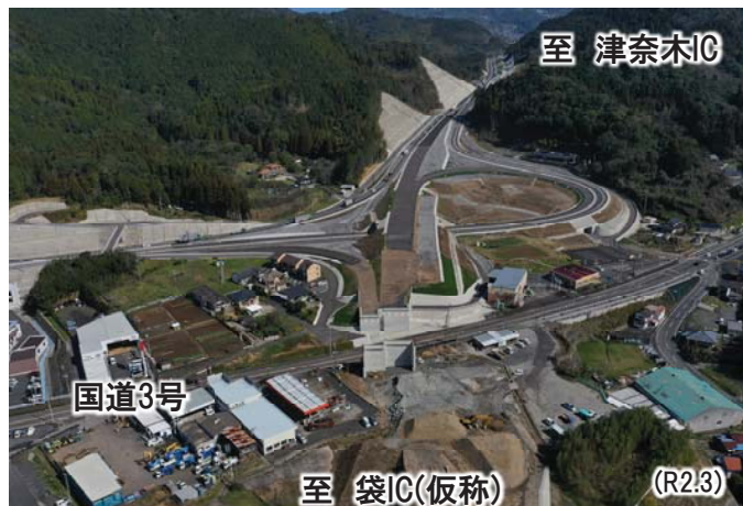
▲水俣IC周辺の工事状況（写真①）
