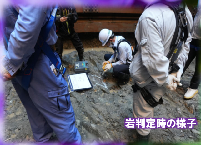
大口径深礎杭
